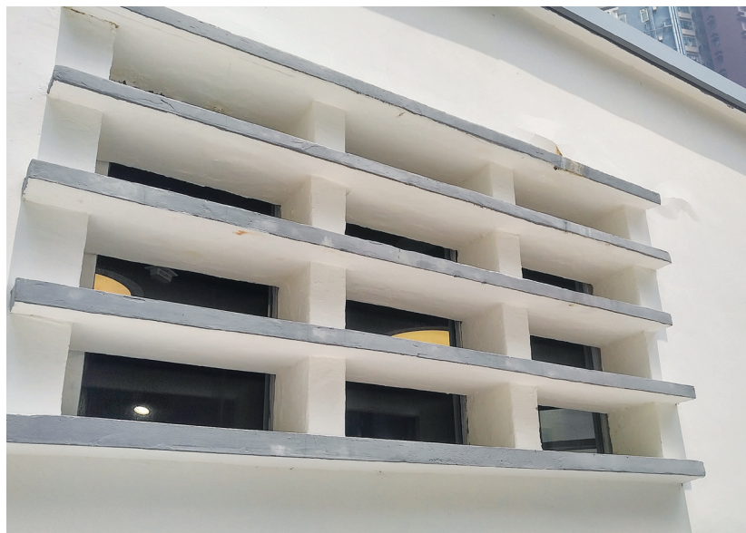
圖 5.08 向後退縮的窗戶以預製的混凝土百葉遮蓋，本來並無裝上玻璃。
