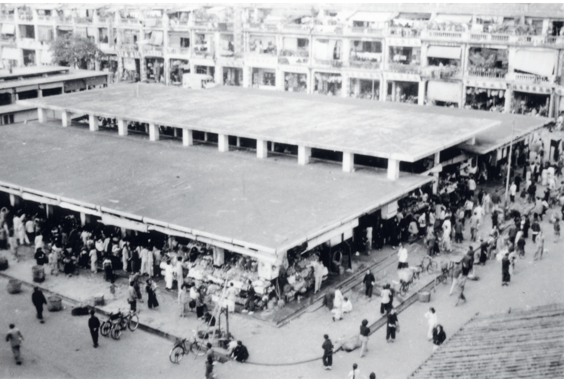
圖3.02 深水埗街市蓋有大型鋼筋混凝土屋頂。 (P1973.488, n.d., photograph, Hong Kong History Museum.)
