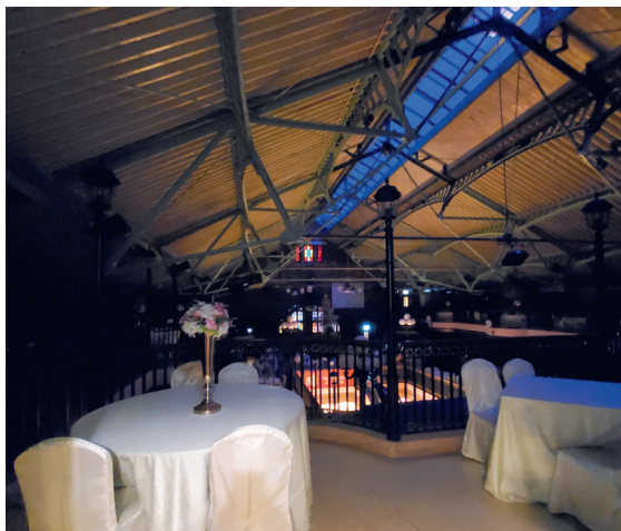
■ 圖 2.19 中庭(左)及以鋼桁架和鋼樑條支撐的金字屋頂(右)。
