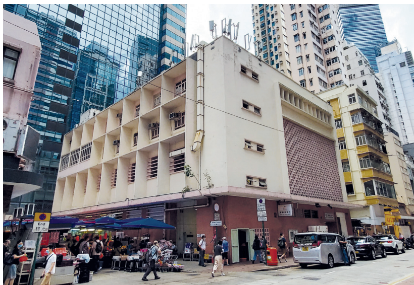
圖 6.03 燈籠洲街市外牆的方格遮陽板和通花磚牆。
