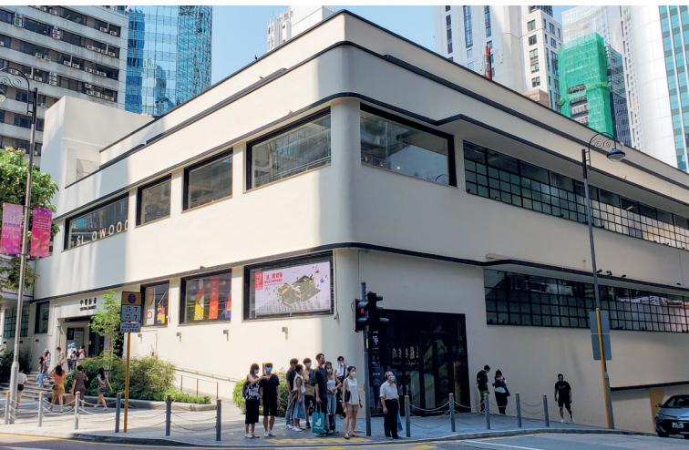
■ 圖 4.31 中環街市的角落修為圓角，加強其具有流線型的外觀。
